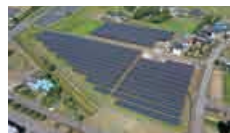
太陽光発電施設 埼玉県加須市
