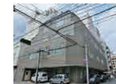
旧建物 (Before・病院建築)
