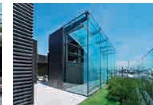
自然換気システム
